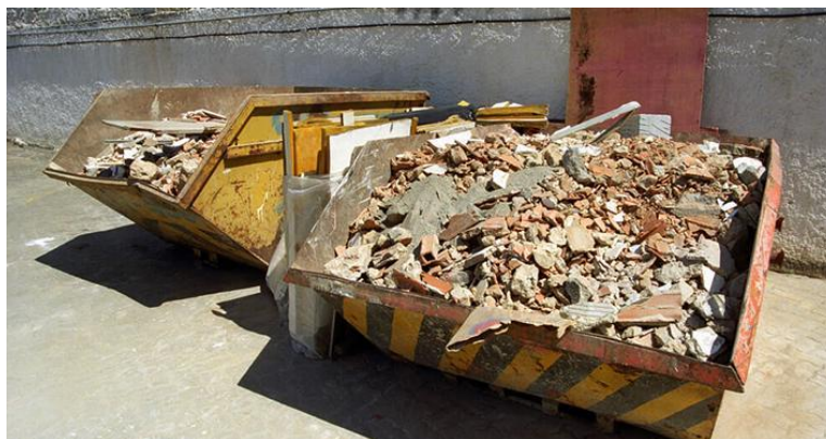
Fonte: Google Imagens – Resíduos de Construção Civil
